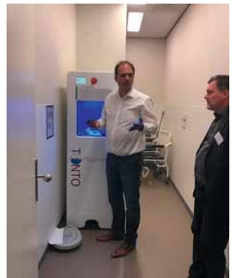
Im Reinier de Graaf Ziekenhuis befindet sich auf jeder Station ein «Tonto», ein Einwurfschacht für die Abfälle, die im Pharmafilter-System aufbereitet werden.
